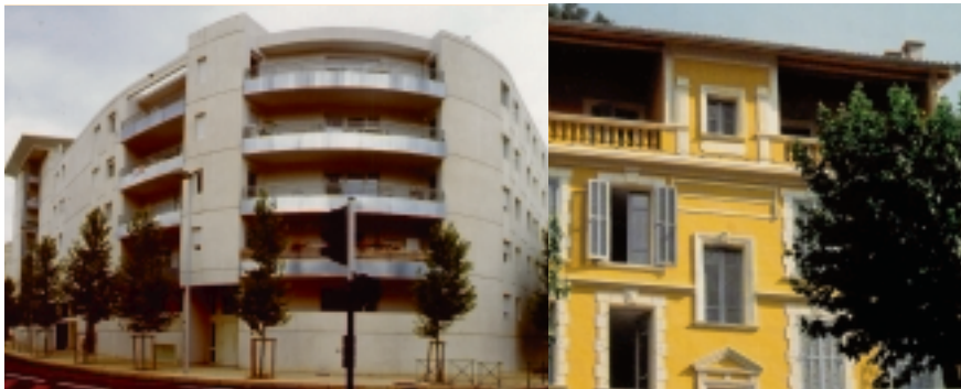
OPAC Montpellier 1996, résidence Euclide, logements PLA, architecte GARCIA-DIAZ (Photo : F. ACHDOU/UNFOHLM)
